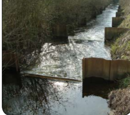
ouvrage au Marais des Mottes
